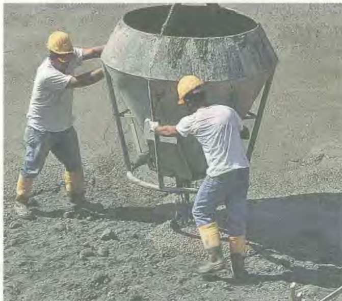
Cantieri Operai edili al lavoro, un protocollo contro le irregolarità
